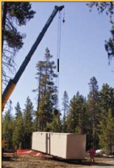
▲ La unidad AX-Mobile™ mas larga pesa 4,535 kg y puede ser transportada sobre plataforma, ferrocarril, contenedor o por helicóptero.
